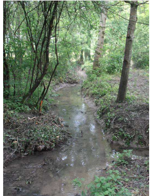
Avant : Végétation buissonnante recouverte par des branches d'arbres morts. Le lit n'est plus visible. Après : Réouverture du milieu par coupe de la végétation buissonnante et extraction des bois morts.
