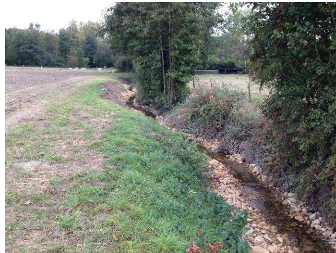
Intervention de talutage des berges, mise en place des matériaux issus du talutage dans le lit avec apport de matériaux terreux et apport de matériaux de granulométrie variée afin de reconstituer le fond du lit (couche armure). ⇒ Rehausse du fond du lit, réduction de la pente et donc du phénomène d'érosion et d'encaissement du lit.
