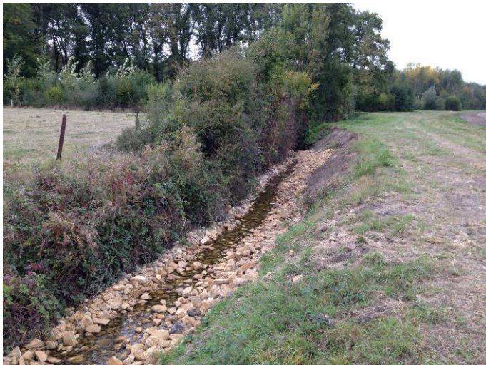
Intervention de talutage des berges, mise en place des matériaux issus du talutage dans le lit avec apport de matériaux terreux et apport de matériaux de granulométrie variée afin de reconstituer le fond du lit (couche armure). ⇒ Rehausse du fond du lit, réduction de la pente et donc du phénomène d'érosion et d'encaissement du lit.
