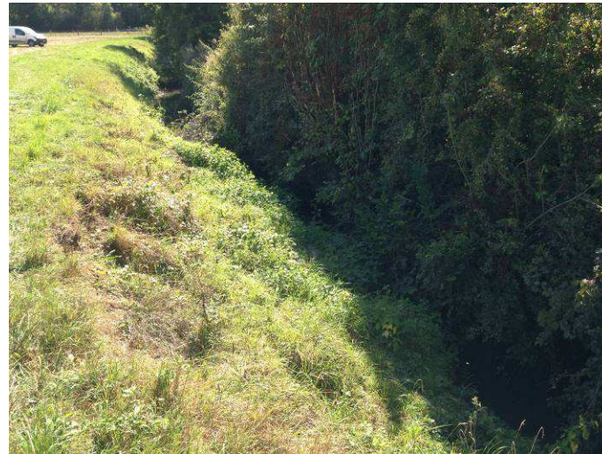
Berge glissée dans le lit du cours d'eau créant un gêne à la circulation des eaux. Réduction de la section d'écoulement
