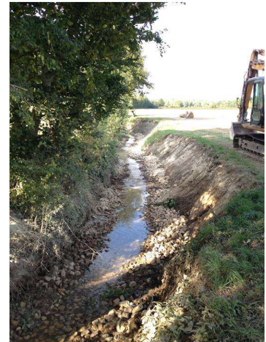
Berge glissée dans le lit du cours d'eau créant un gêne à la circulation des eaux. Réduction de la section d'écoulement
