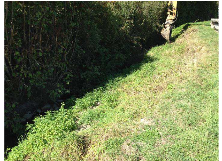
Berge glissée dans le lit du cours d'eau créant un gêne à la circulation des eaux. Réduction de la section d'écoulement
