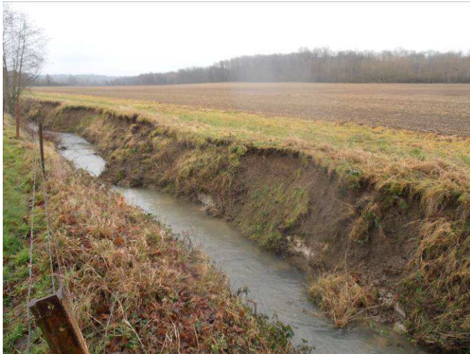
Constat à l'hiver : observation d'érosion des berges importante. Présence de berges abruptes avec un lit encaissé
