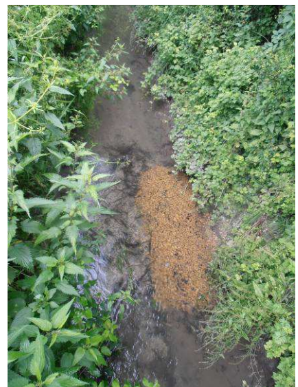
Réalisation de banquettes minérales. Observation de décolmatage et création de zone de courant.
