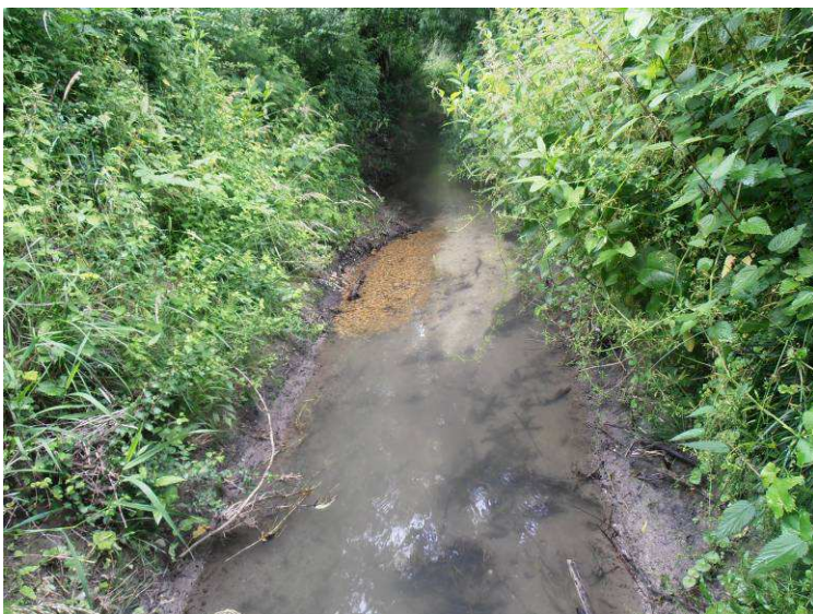
Réalisation de banquettes minérales. Observation de décolmatage et création de zone de courant.
