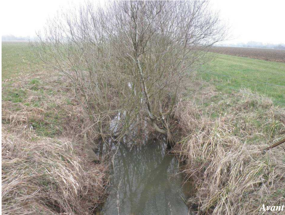
Intervention sur la noue dans la partie prairie et zone de culture : dégagement du lit mineur
