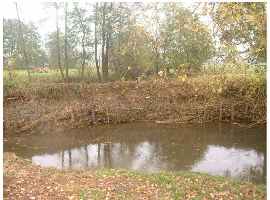
Réalisation d'un peigne en prévision d'une coupure de méandre
