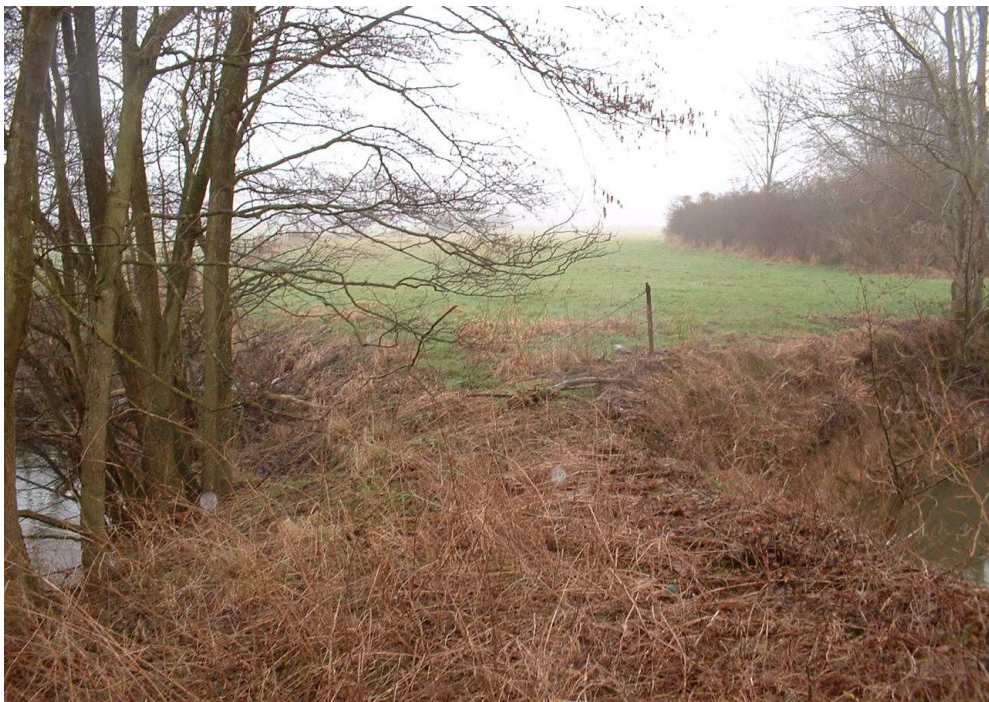
Réalisation d'un peigne en prévision d'une coupure de méandre
