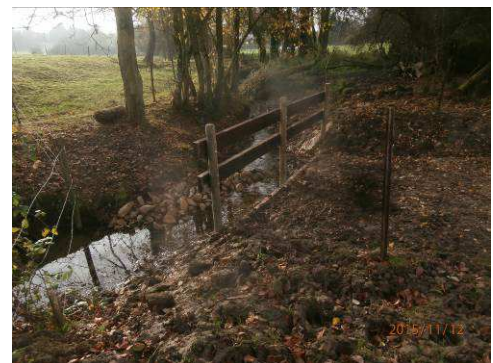
Tronçon BC : Désencombrer et recharger le lit pour rendre le ruisseau plus attractif
