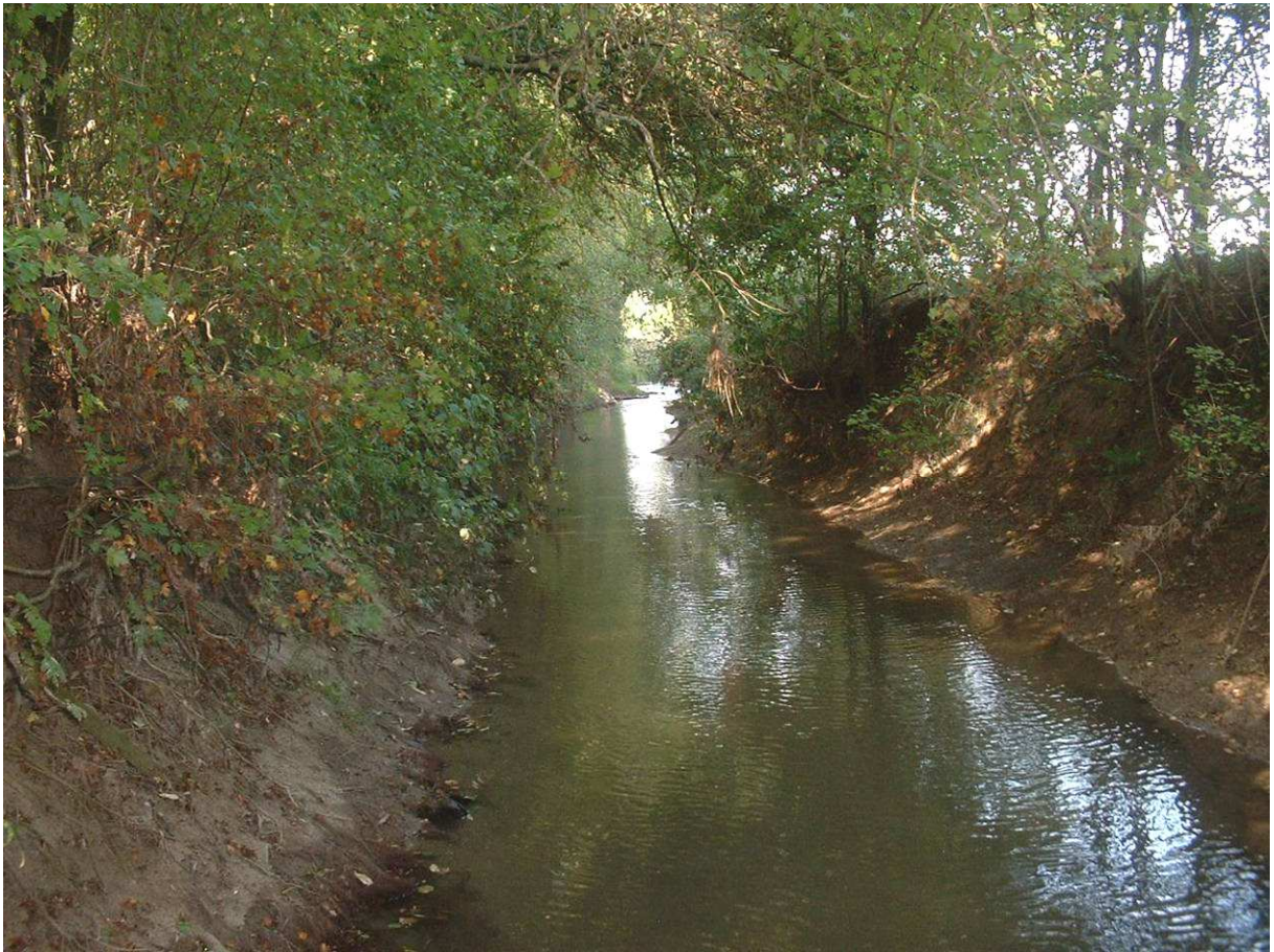
tronçon homogène : alternance de déflecteur et radier et apport de gravier
