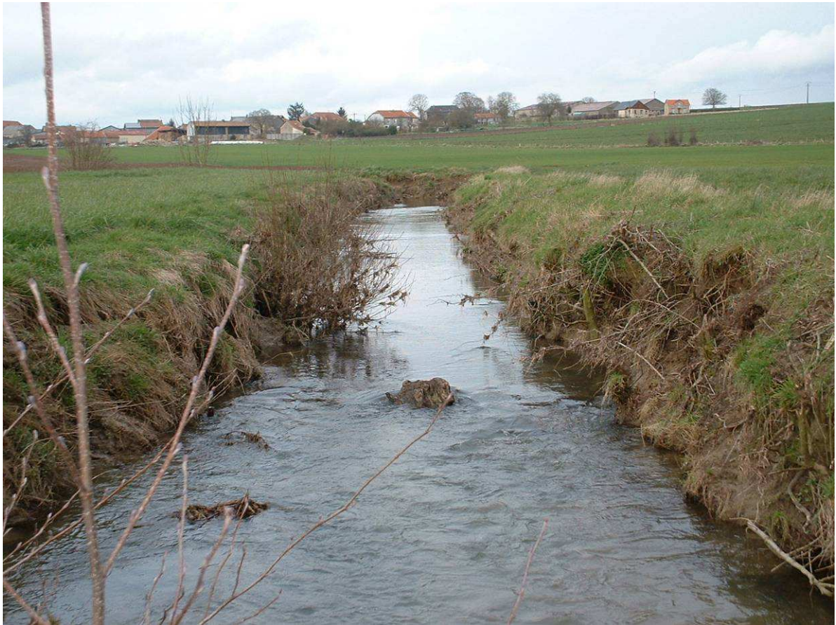
Zone homogène : réalisation de peignes et déflecteurs
