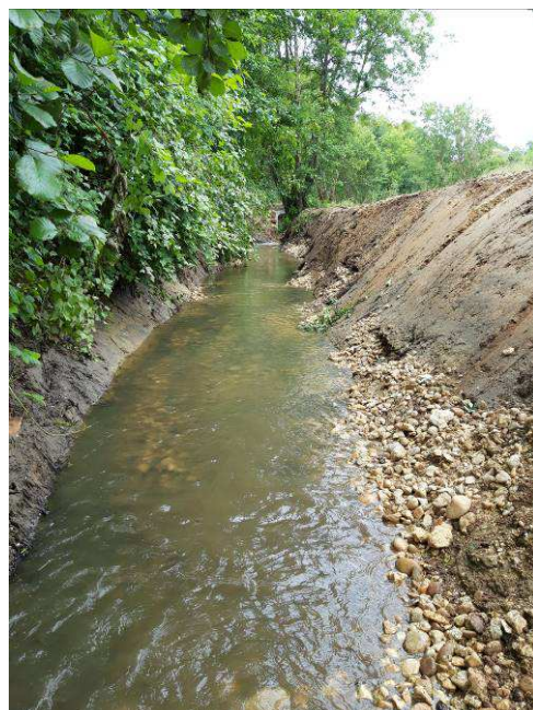
A l'amont de l'ouvrage, extraction des sédiments et création d'une recharge sédimentaire sur une longueur de 55ml pour reconstituer un lit et une pente homogène.
