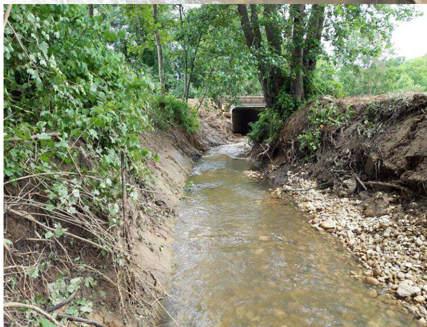
A l'amont de l'ouvrage, extraction des sédiments et création d'une recharge sédimentaire sur une longueur de 55ml pour reconstituer un lit et une pente homogène.
