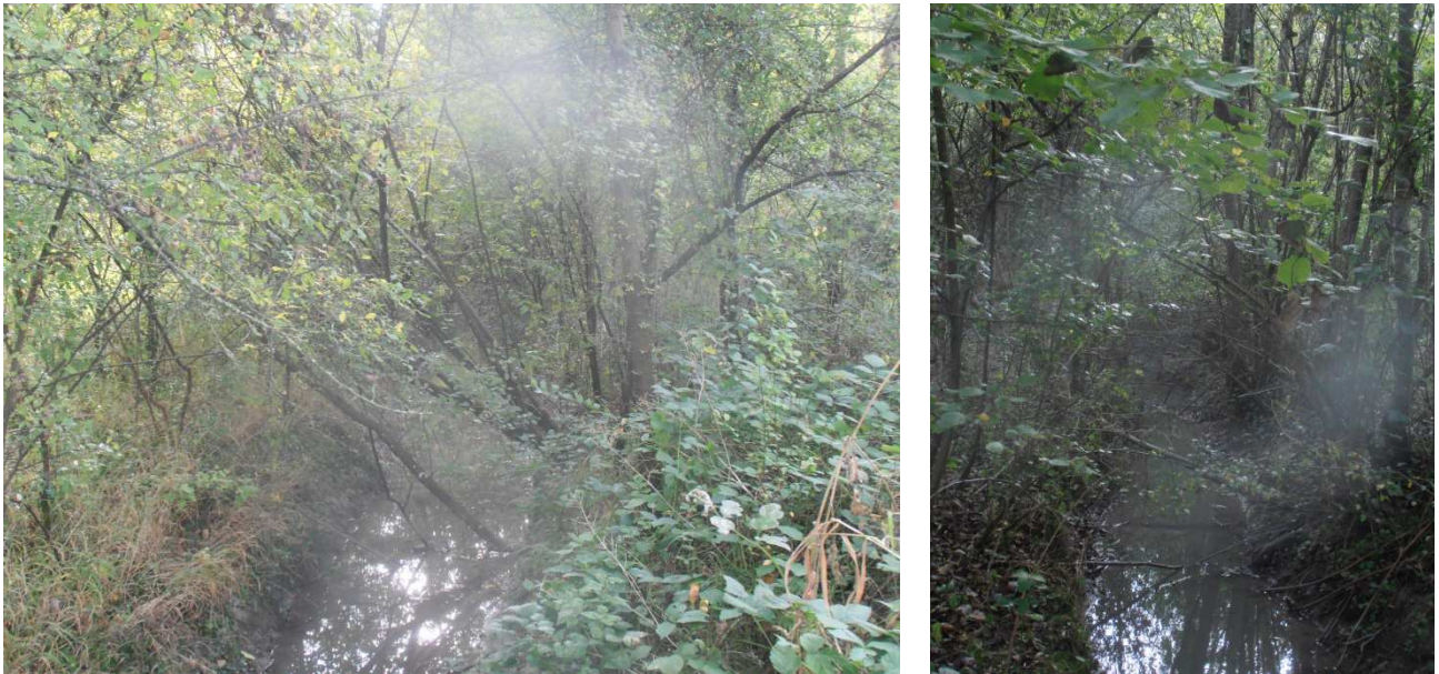
Végétation arborescente développée et présente sur un secteur homogène colmaté. Intervention de coupe afin de dégager le lit et réalisation de peignes afin de diversifier les écoulements et permettre de décolmater le fond du lit.
