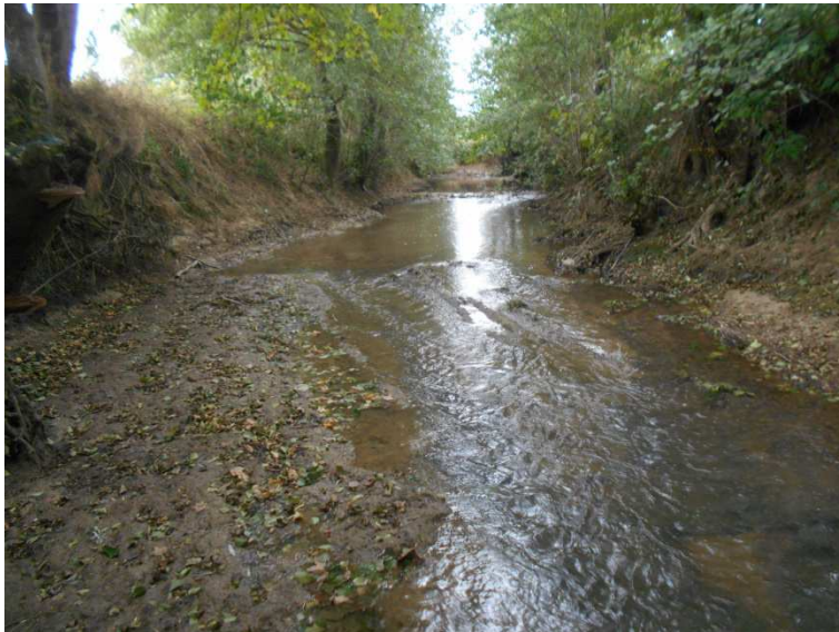
Observation de sillons d'écoulement dans le bed rock. Réalisation d'une recharge en matériaux afin de reconstituer un substrat et limiter l'encaissement.
