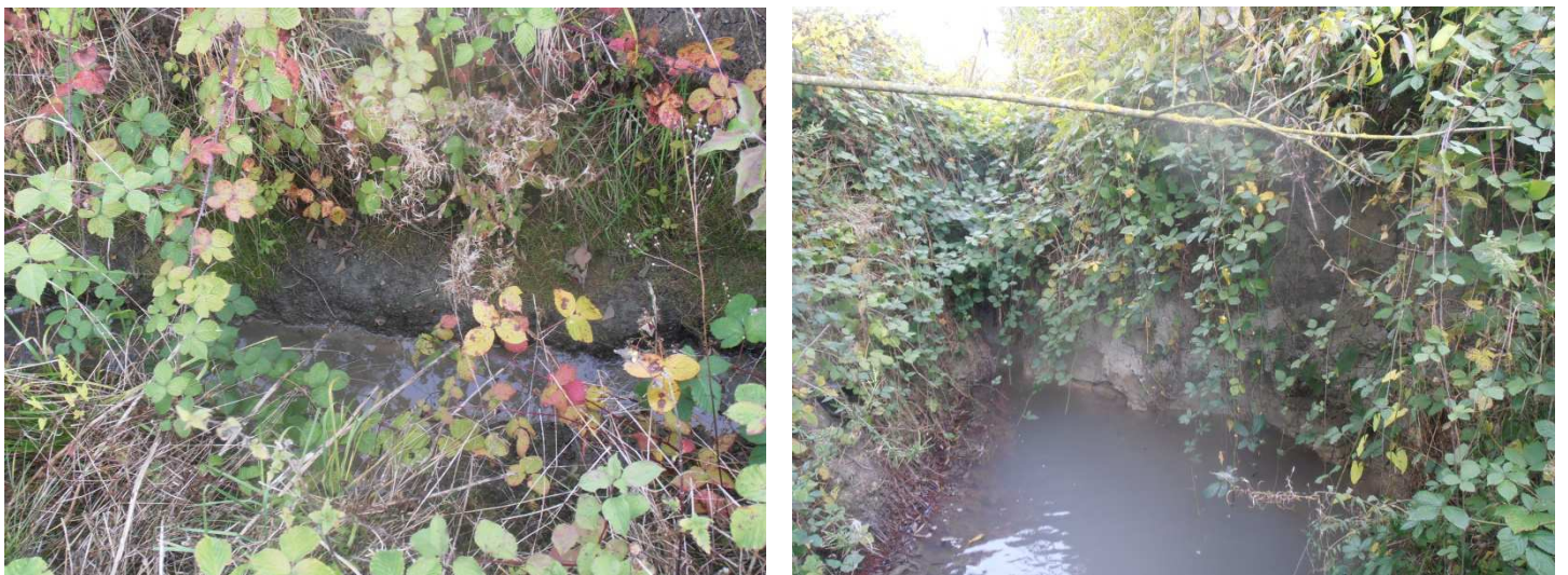
Secteur décapé en cours d'érosion. Création d'une fosse et encaissement du lit (berge abrupte sur 4m en rive gauche). Talutage de la berge avec dépôt des matériaux dans le lit afin de rehausser le niveau et réalisation d'une recharge homogène en matériaux afin de reconstituer un substrat, l'objectif étant de limiter le phénomène d'érosion.
