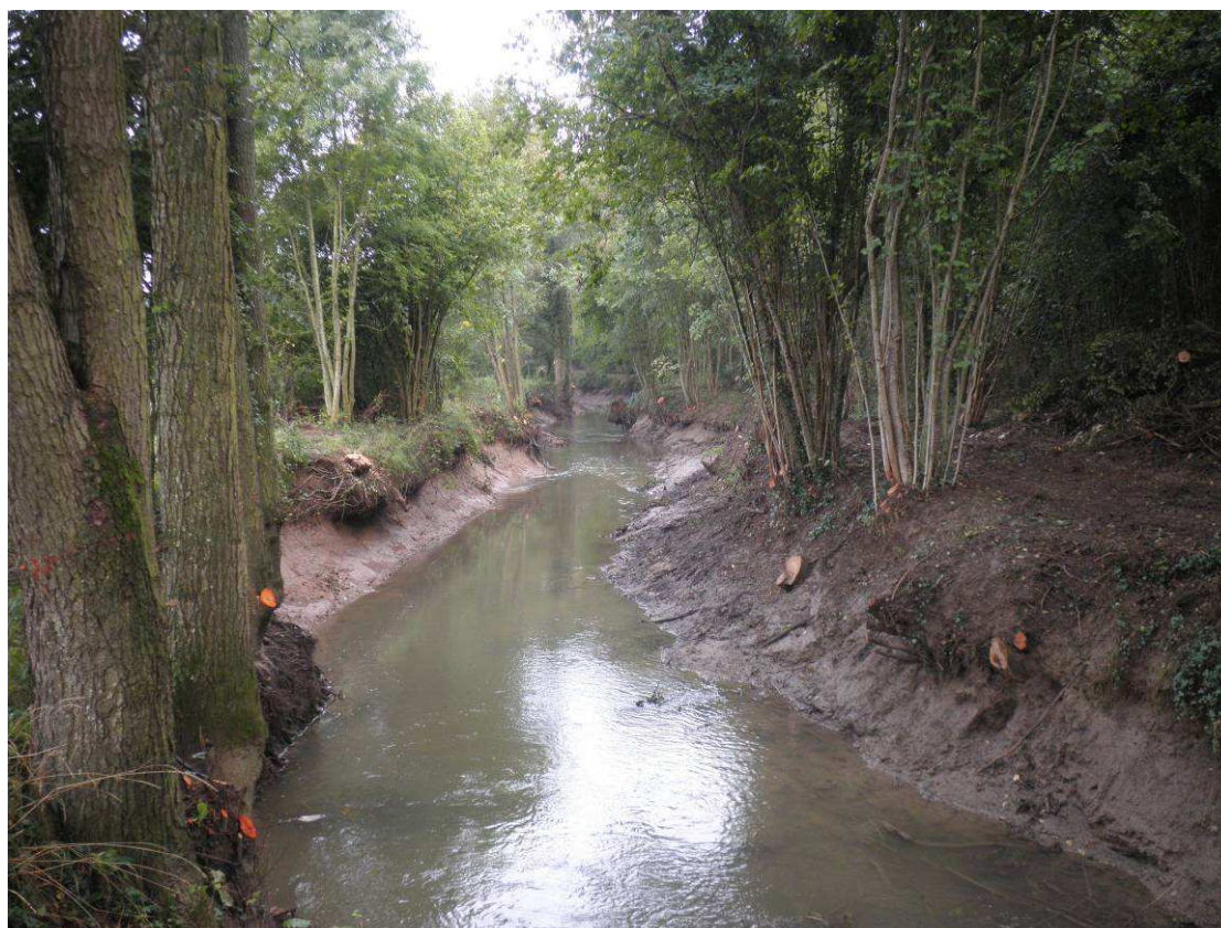
Tronçon après travaux, les vannes du moulin sont levées, noter la hauteur de marnage d'environ 1 m
