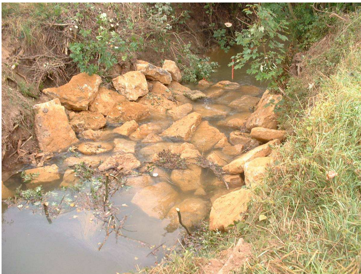
Mise en place des gros blocs formant le seuil
