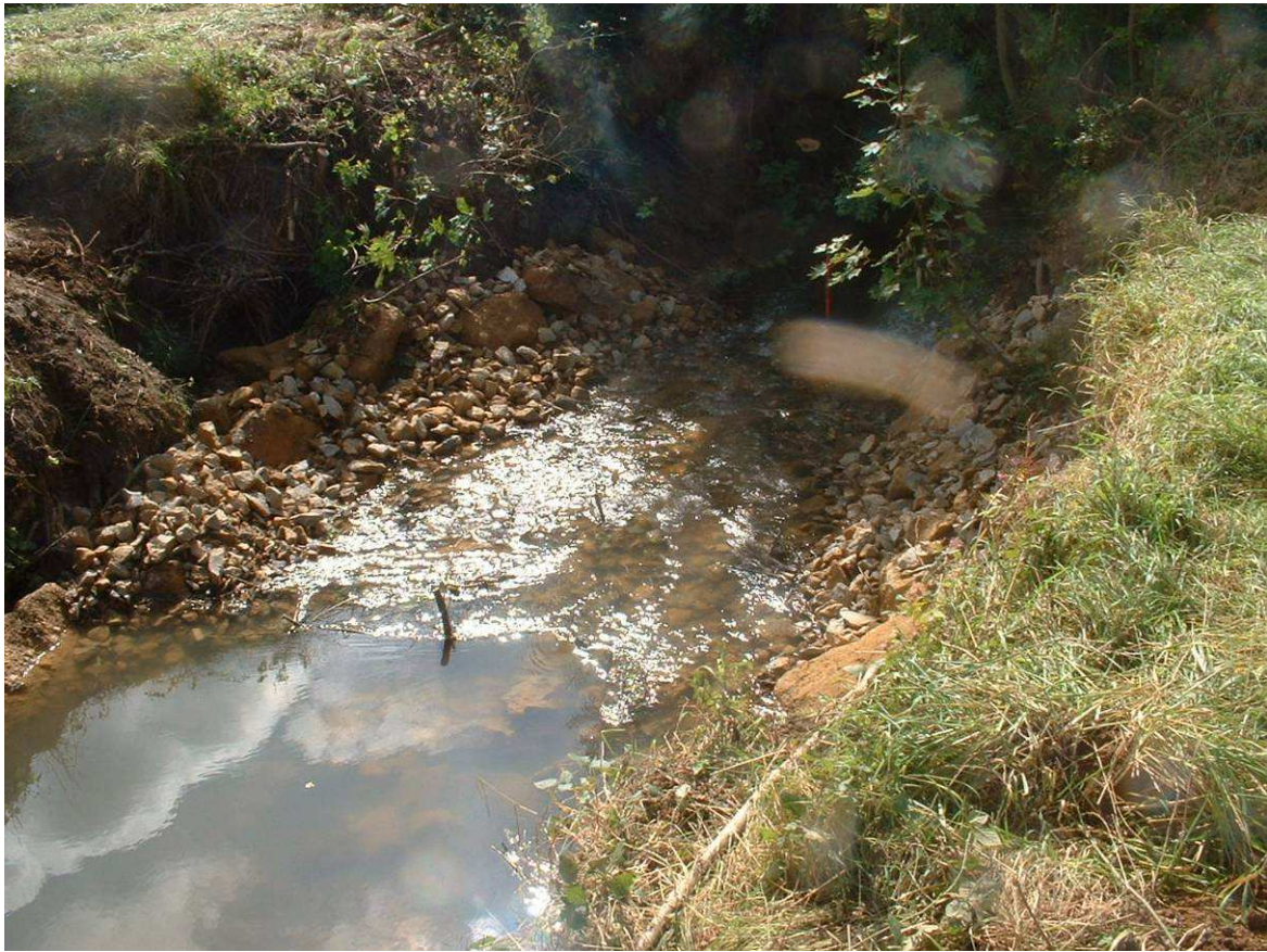
Comblement par du concassé des interstices entre les gros blocs
