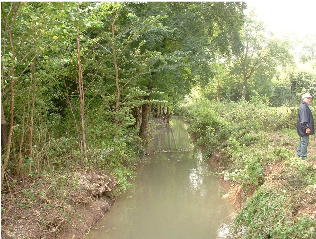
Après travaux de coupe sélective
