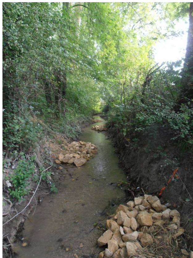
Avant : Observation de plusieurs zones de surlargeur présentant très peu ou pas de courant. Après : Réalisation de banquettes minérales pour réduire la largeur du lit et diversifier les écoulements.
