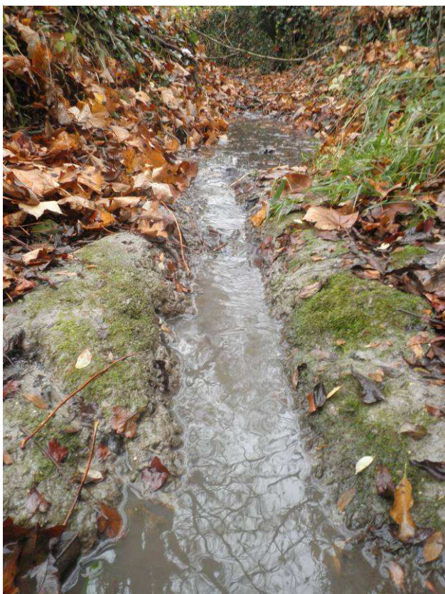
Avant : Observation de zones décappées (absence de substrat) avec création d'un chenal central d'écoulement. Après : Apport de matériaux afin de recharger le fond du ruisseau et permettre de recréer un substrat « naturel ».
