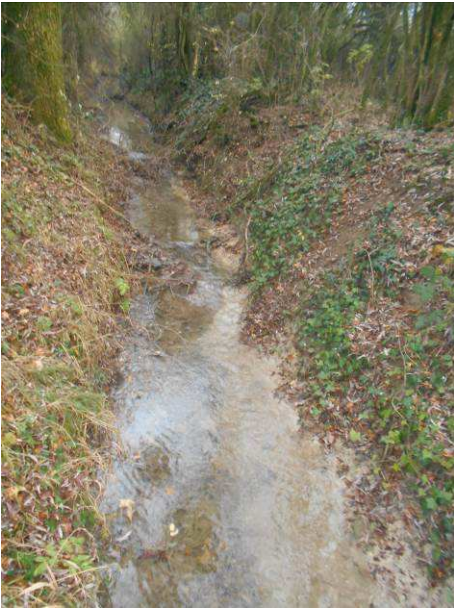
Zone d'écoulement sur le bed-rock : réalisation d'un radier et recharge en graviers sur la partie amont afin de limiter le risque d'érosion.
