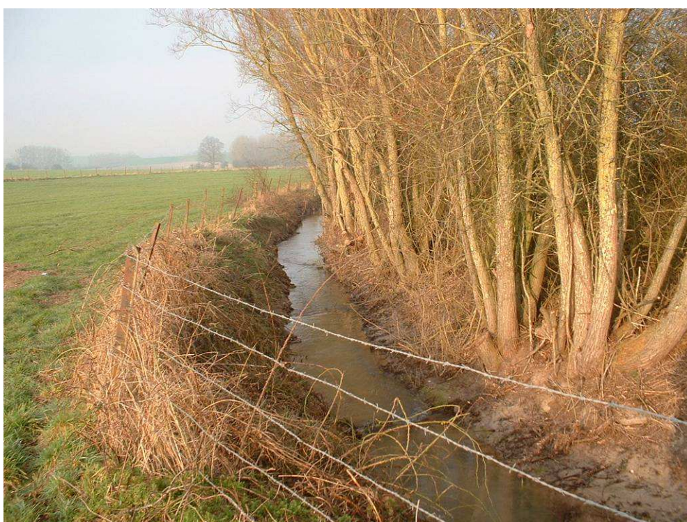
Ruisseau après intervention
