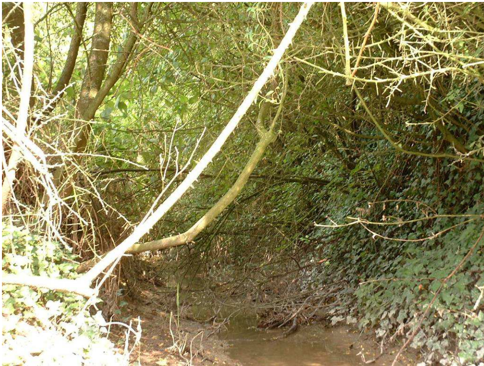
Aval du fossé de SORBON avant travaux
