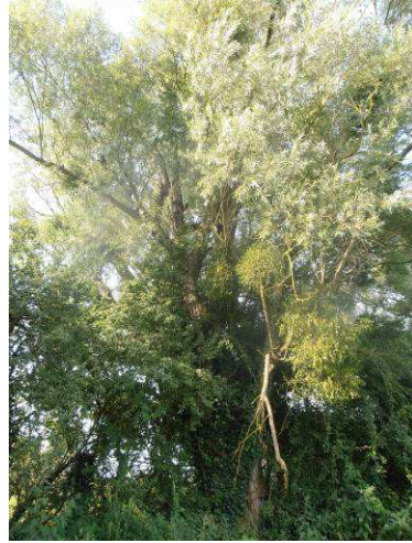
Présence de vieux saules à mettre en têtard pour éviter casse ou chute.
