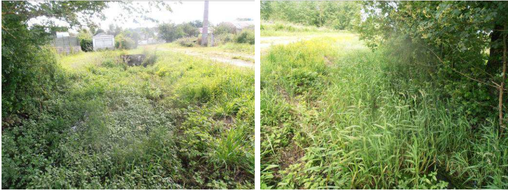
Secteur en surlargeur colmaté. Réalisation d'un chenal d'écoulement dimensionner aux écoulements du cours d'eau avec création de banquettes végétalisées.
