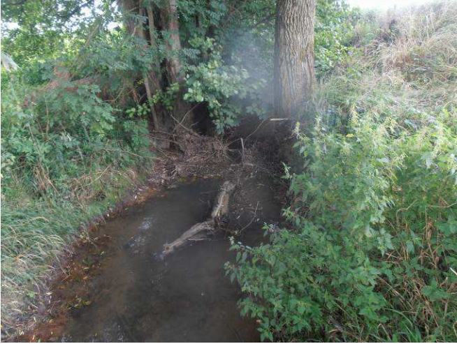
Présence d'encombres dans le ruisseau qu'il faudra extraire.
