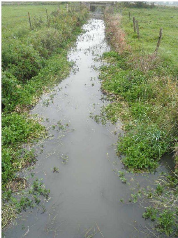
Réalisation de banquettes avec le cresson afin limiter la progression de l'espèce mais également dynamiser le cours d'eau en diversifiant les écoulements.
