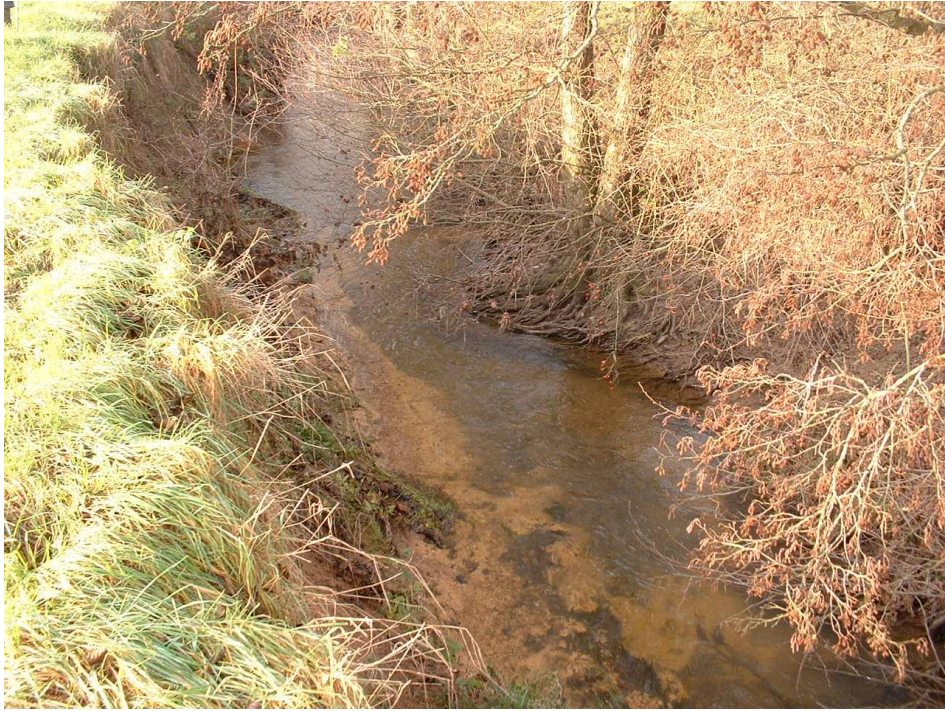
Aval du chemin de verrière problème encaissement dégradation du lit mineur
