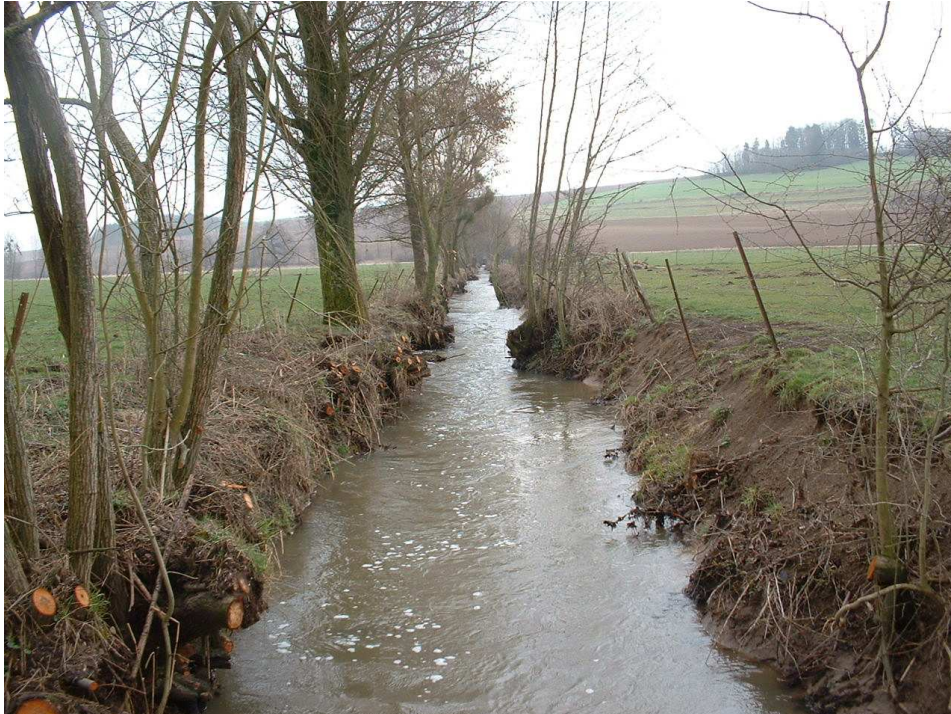
Après travaux et mise en place de bouture sur la rive gauche
