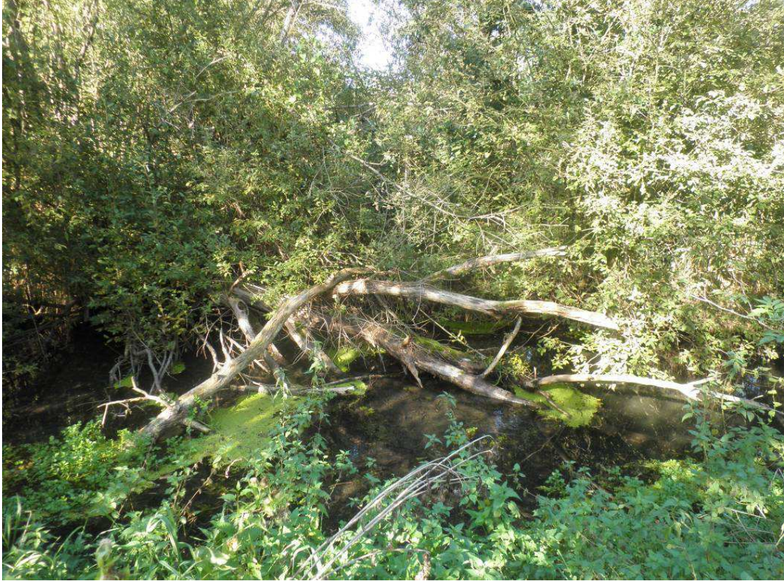
Constat : Vieux peuplier mort bordant la rivière et tombé suite au vent.
