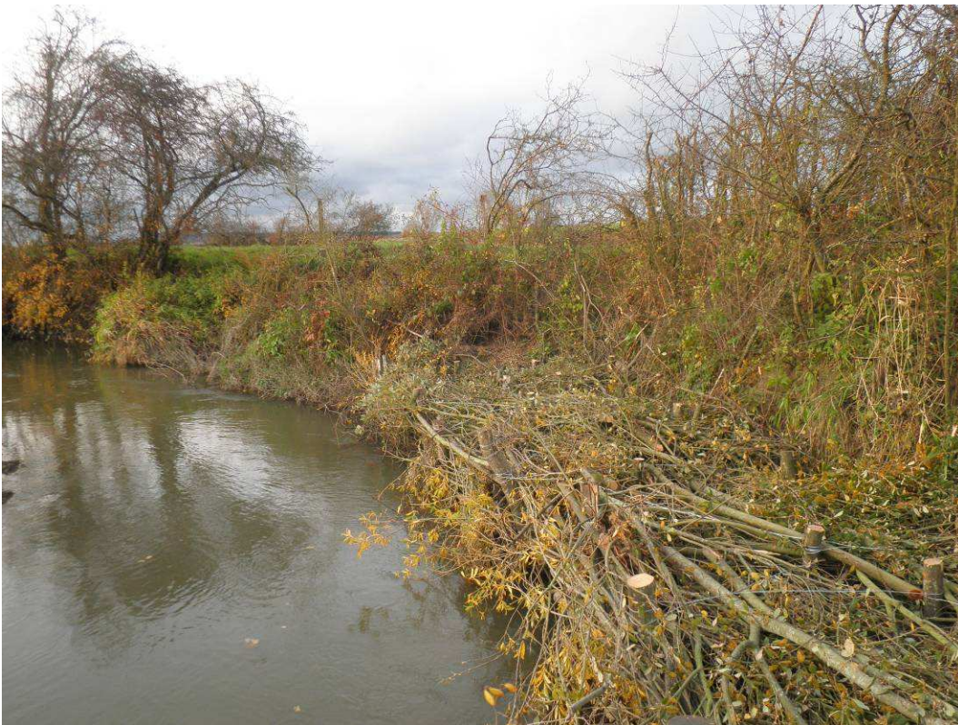
Réalisation d'un peigne végétale sur zone affaissement berge sur la Bar
