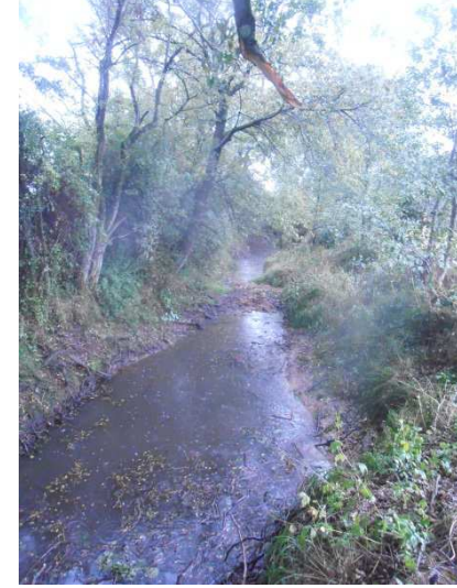
Extraction de l'embâcle limitant les écoulements et recharge sédimentaire
