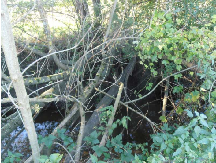
Présence de végétation buissonnante tombée dans le lit risquant de créer des encombres à l'écoulement.
