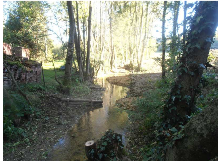
Confection d'un lit d'étiage permettant le décolmatage du fond du ruisseau
