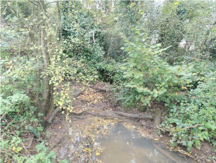
Présence d'encombres dans le lit du ruisseau qu'il faudra extraire
