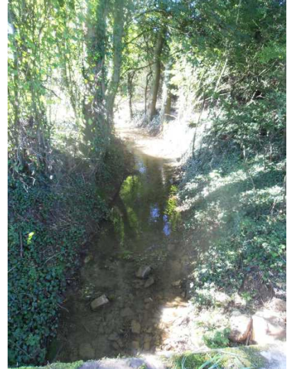
Extraction des encombres, coupe de la végétation rivulaire et installation de blocs pour diversifier les habitats
