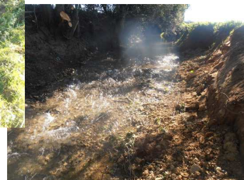
Réalisation d'un radier & Implantation de boutres de saules.
