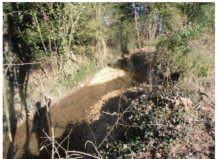
Confection d'un lit d'étiage permettant le décolmatage du fond du ruisseau
