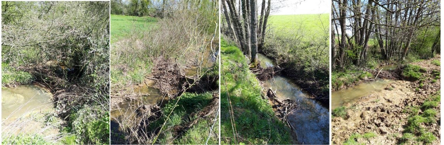
Présence d'encombres dans le lit du ruisseau qu'il faudra extraire
