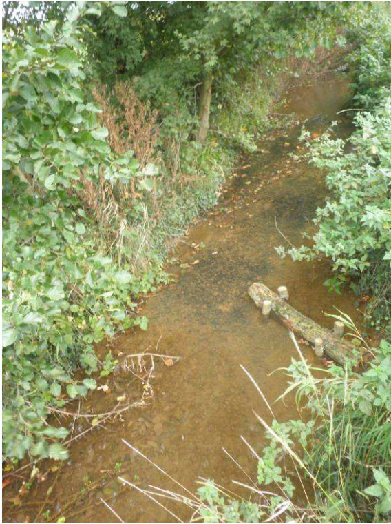
Réalisation d'aménagements rustiques (déflecteurs) sur des secteurs rectilignes afin de diversifier les écoulements.
