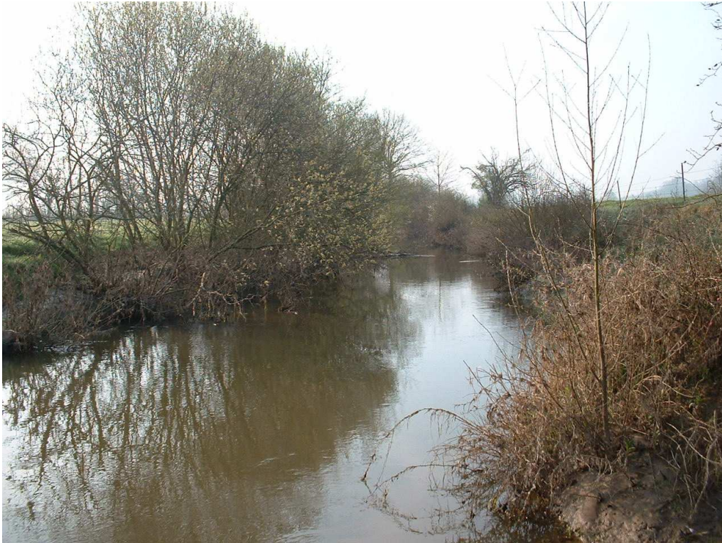
Travaux de coupe sélective en amont du pont de Ambly
