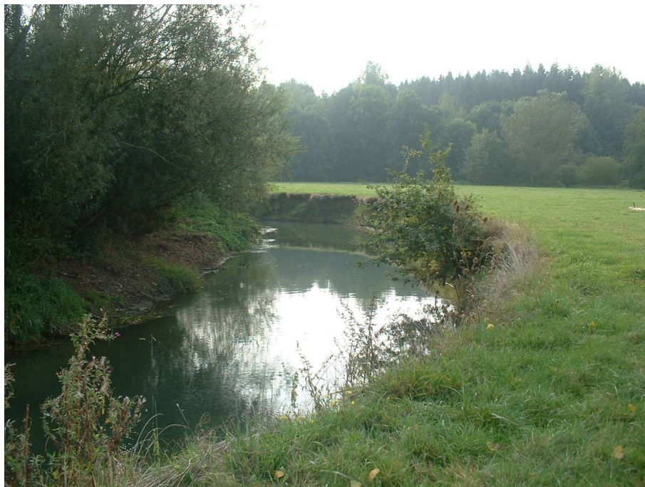
Après Travaux d'entretien
