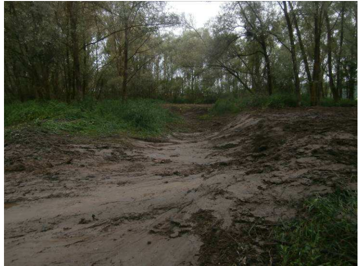
Réouverture du milieu et reprofilage d'un chenal d'écoulement facilitant la progression des eaux et l'installation d'une végétation adaptée.
