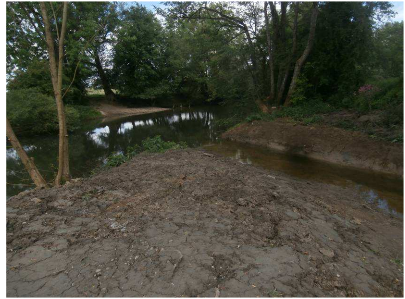
Coupe et extraction des buissonnants. Reconnexion de l'annexe avec la rivière.
