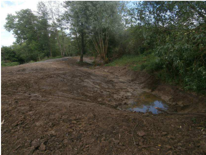
Dégagement de l'annexe et retalutage pour accueillir une végétation herbacée
