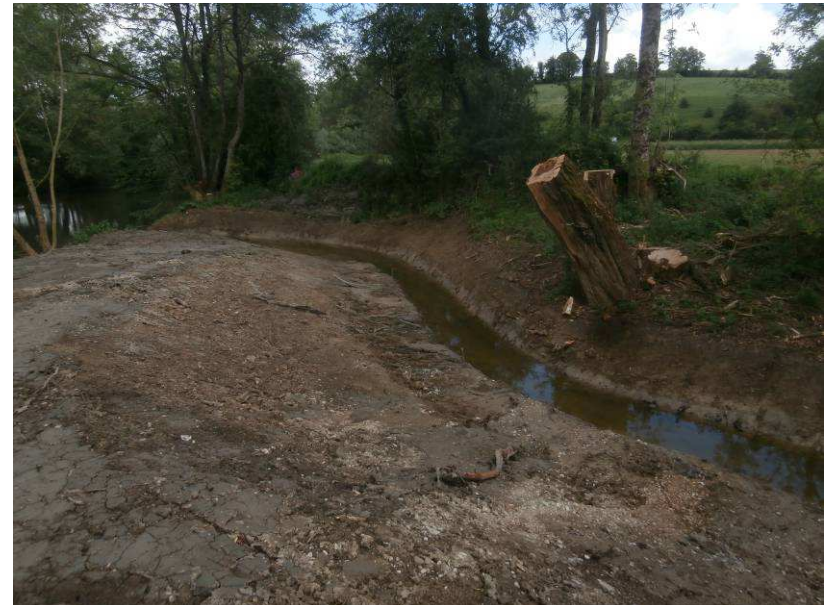
Reprise de la cépée de saule en têtard et création d'un chenal d'amené.
