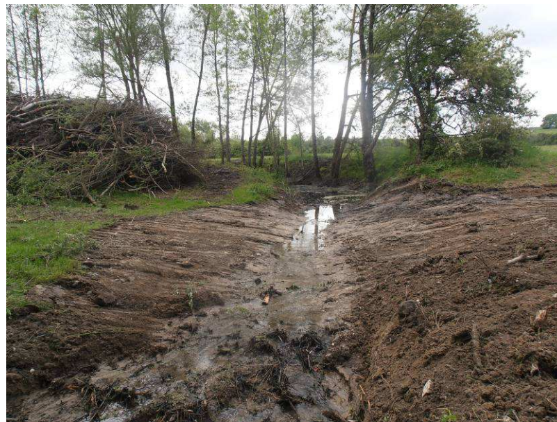
Connexion avec la rivière perturbée. Restauration de la connexion avec création d'un chenal d'écoulement.
