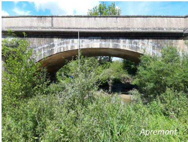
Comblement partiel de l'arche centrale par dépôt de sédiments (4.10m disponible) et encombrement total de l'arche droite (sédiments et végétation - 3.8m disponible).
