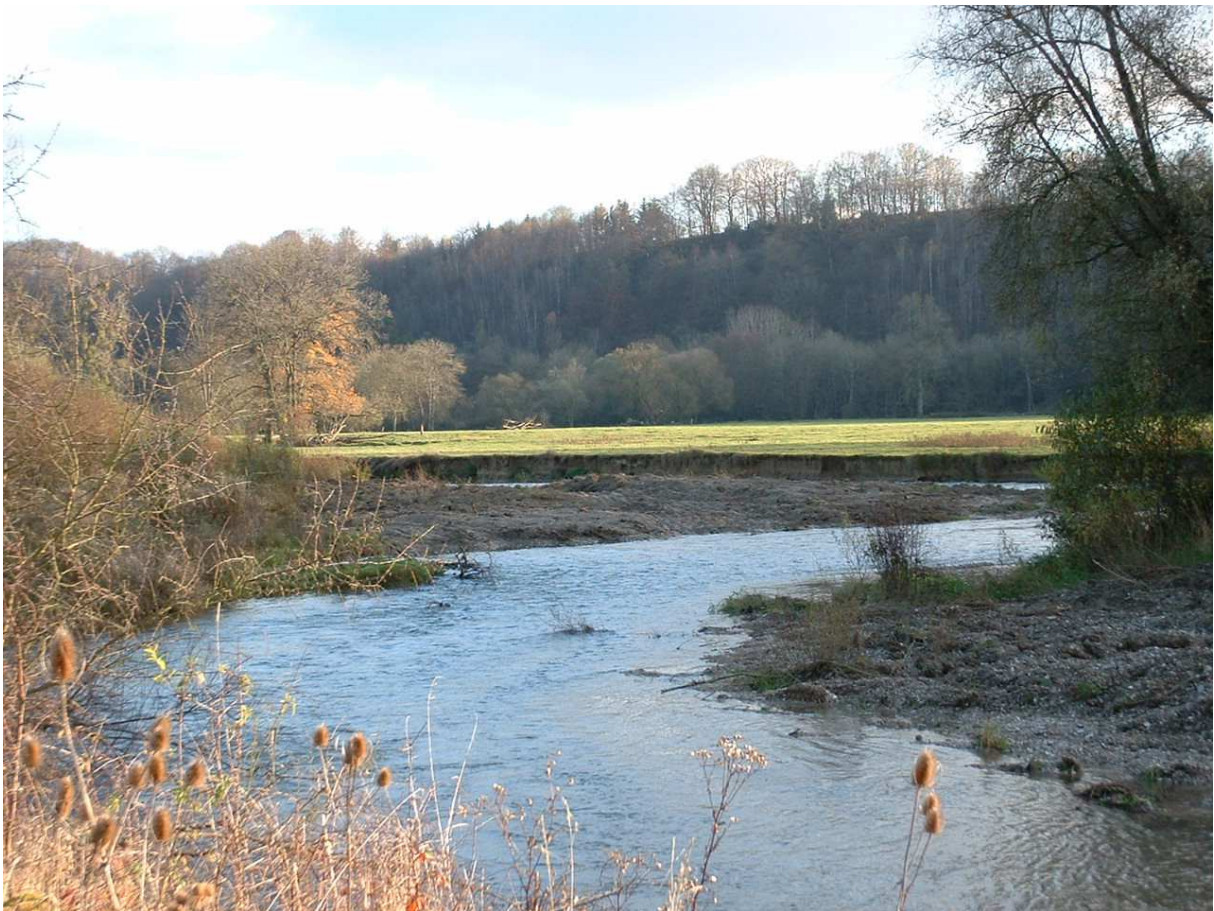
Extraction embâcle peupliers et scarification de l'atterrissement vue aval amont
