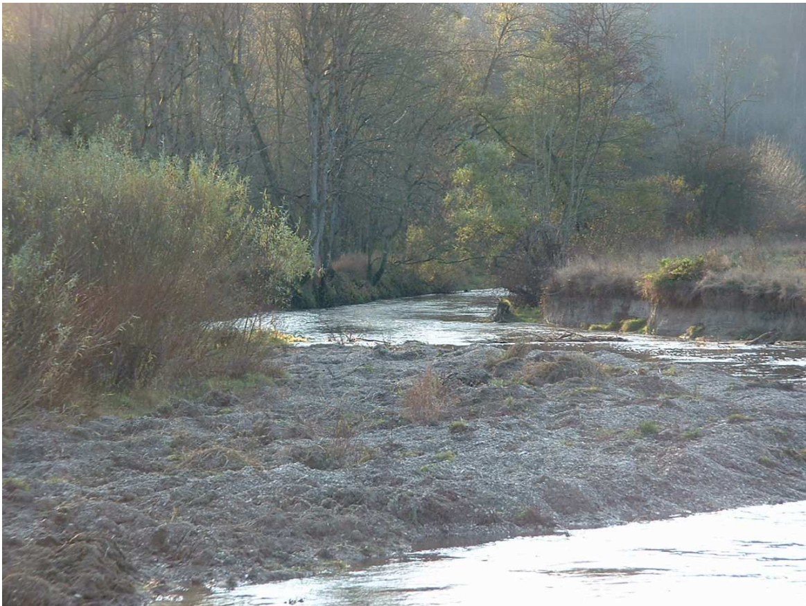
Extraction de l'embâcle en arrière plan et scarification de l'atterrissement
