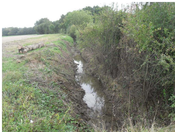
Végétation fortement développée en aval du pont nuisant à l'écoulement : intervention de désencombrement du lit permettant de remettre en lumière et restaurer les écoulements.
