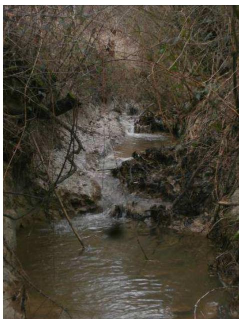
Végétation fortement développée en aval du pont nuisant à l'écoulement : intervention de désencombrement du lit permettant de remettre en lumière et restaurer les écoulements.
