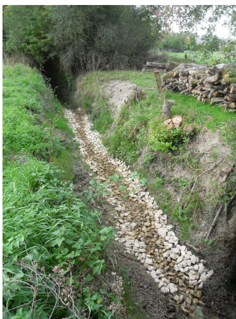
Végétation fortement développée en aval du pont nuisant à l'écoulement : intervention de désencombrement du lit permettant de remettre en lumière et restaurer les écoulements.
