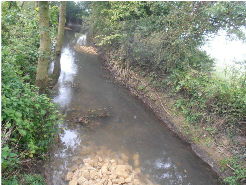
Avant : Secteurs homogènes peu diversifiés avec quelques zones colmatées ; Intervention : mise en place de déflecteurs=> diversité et décolmatage du ruisseau.
