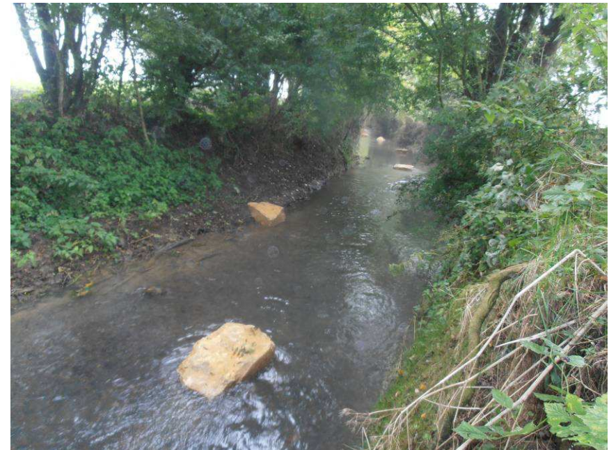
Avant : Secteurs homogènes peu diversifiés ; Intervention : Mise en place de blocs aléatoirement pour diversifier les écoulements et le tronçon (création de caches...).
