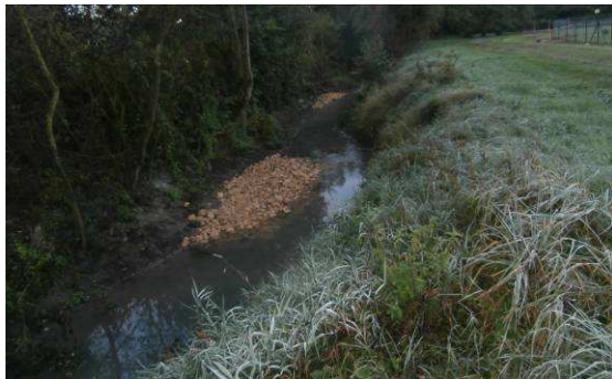
Installation d'aménagements sur ces secteurs afin de décolmater le fond du lit du ruisseau et remettre à jour le substrat originel.
