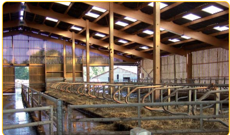
Un bâtiment compact limite les déplacements des vaches
