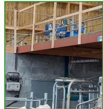
*Pré refroidisseur tubulaire placé au-dessus de robots de traite*
