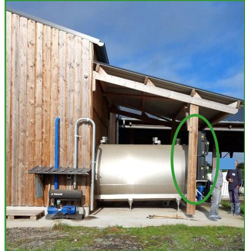
*Sur l'illustration de gauche, un système d'ouverture modulable en face des groupes du tank, et sur celle de droite, l'arrière du tank avec les groupes positionnés en dehors de la laiterie sur une dalle bétonnée couverte*
